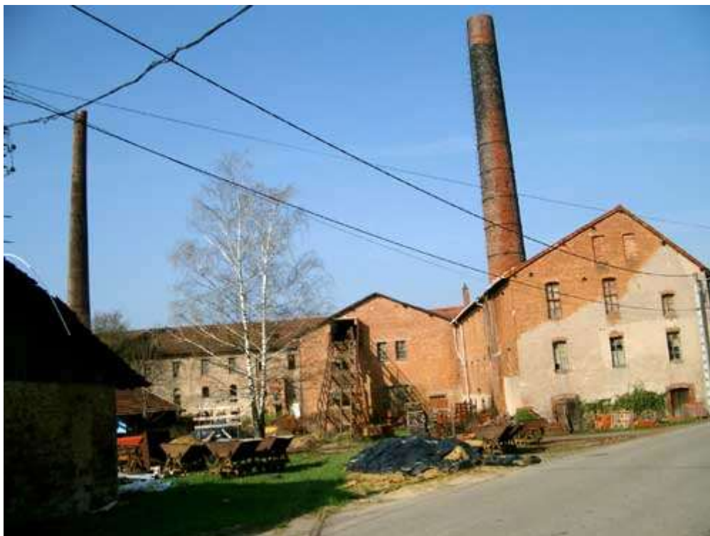
La tuilerie (photo récente)
