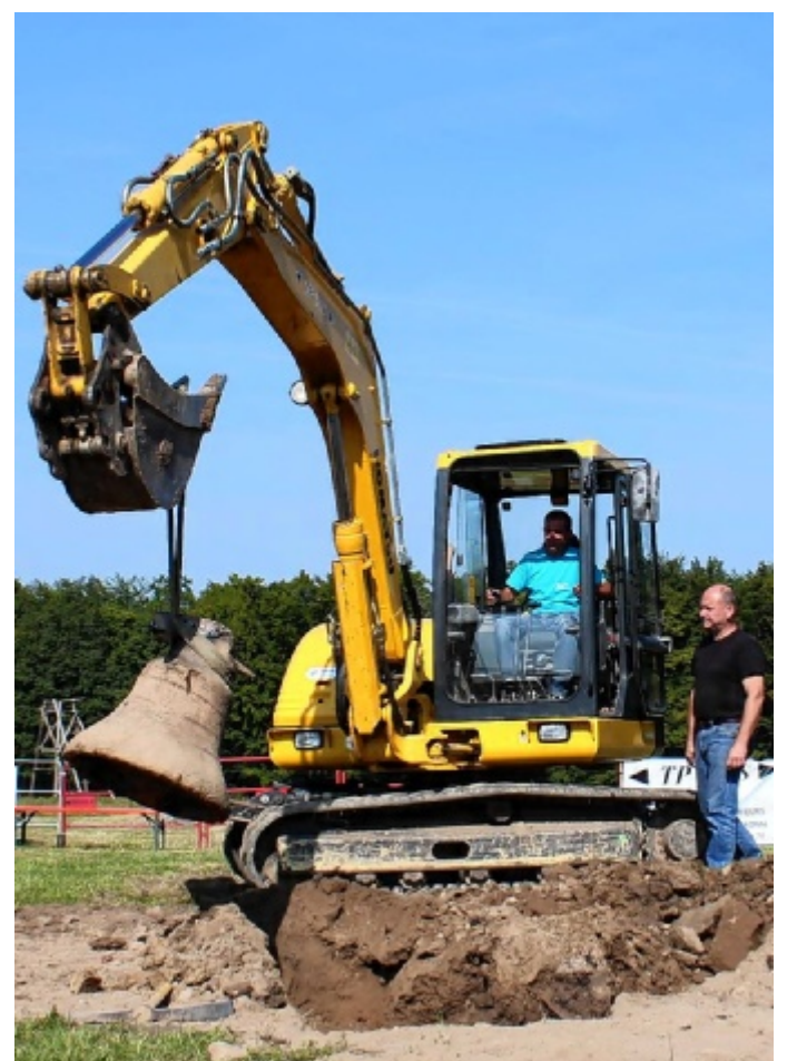
... puis sorties de terre à grand renfort de machines.
