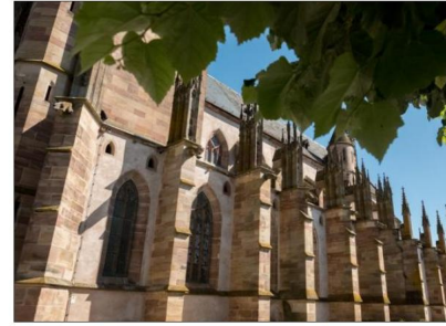
Réputée pour ses magnifiques vitraux du 13 e siècle, la collégiale Saint-Florent à Niederhaslach a été construite par le fils de l'architecte de Strasbourg, Erwin von Steinbach.
