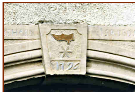
Photo 3 : 45 Grand'rue Encadrement mouluré de 1796 : agrafe à deux cartouches ; cartouche supérieur décoré d'un sabot - emblème du sabotier - et d'une étoile à six branches
