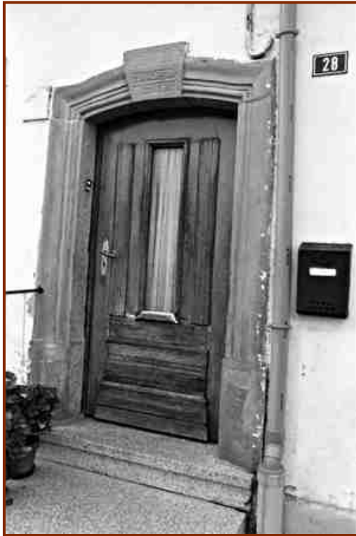
Photo 8 : 28 rue des Menuisiers
