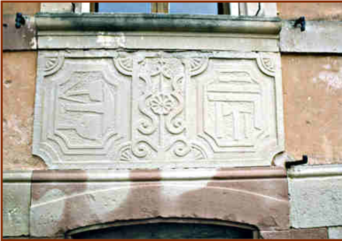
Photo 16 : 2 rue des Menuisiers
