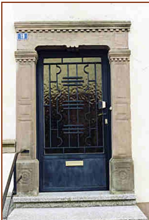
Photo 23 : 19 rue des Menuisiers
